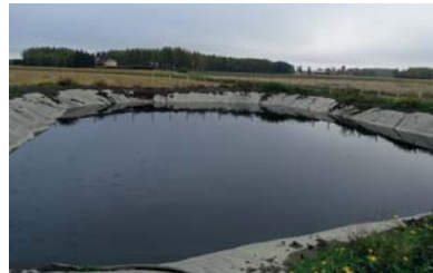
Kalle Vainio rakensi tilalleen tuhannen kuution kumialtaan biokaasulaitokselta tuotavaa lietemäistä mädätettä varten. Kuva: Hia Sjöblom
